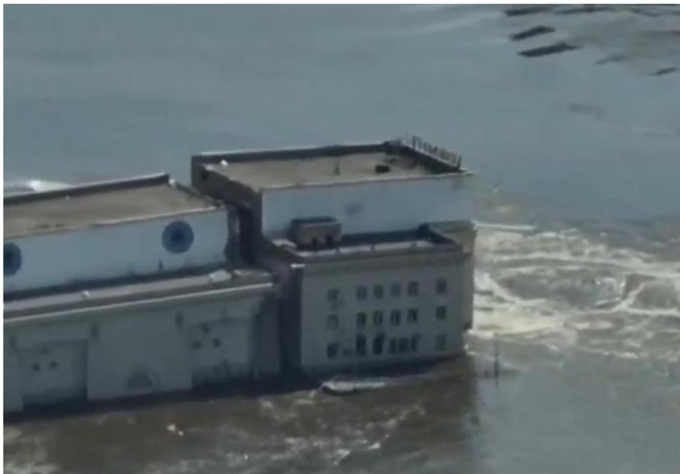
Entre l'usine et l'écluse, l'ouvrage est constitué d'un barrage en remblais, nettement plus sensible à l'érosion. Il n'est donc pas particulièrement étonnant qu'il se soit érodé suite aux mouvements de fondation, alors que les blocs de l'usine ont été nettement moins affectés.
