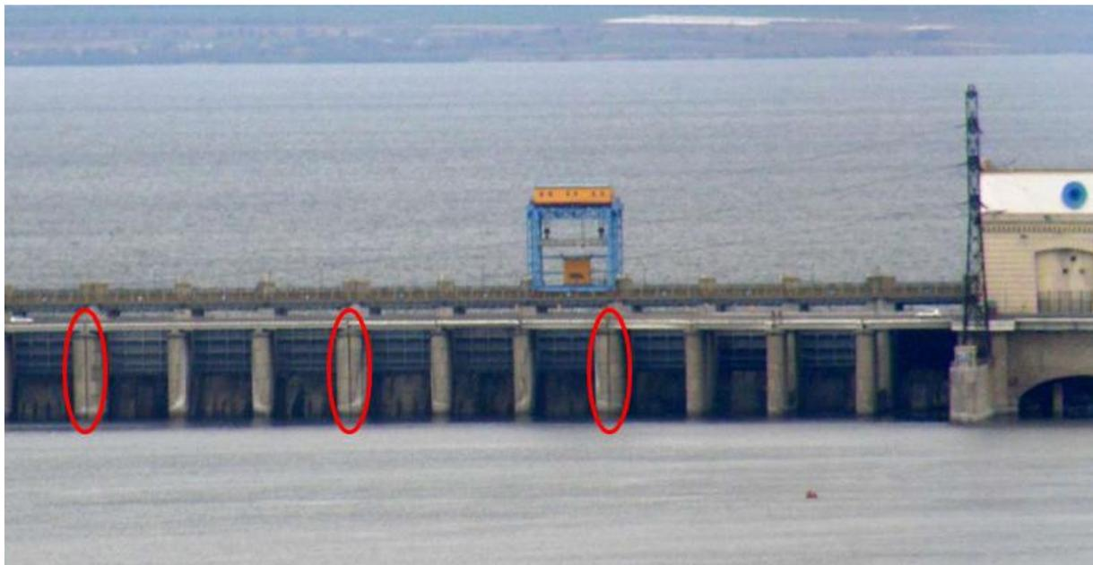
Au niveau des 4 premières passes, comme on le voit sur la photographie ci-dessous, il n'y a pas de « double pile » entre les passes 1 et 2 au niveau de la pile de pont aval, alors que le joint est bien présent dans l'épaisseur de la pile sur l'évacuateur.
