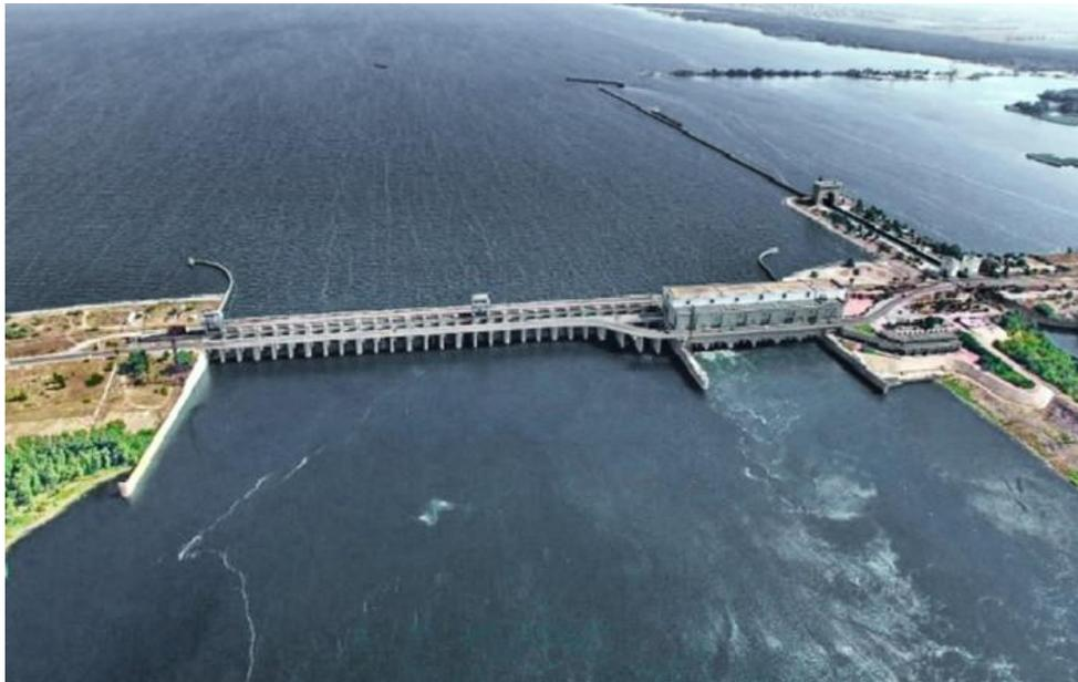
L'aménagement de Nova Kakhovka se compose, de la rive droite vers la rive gauche : d'un barrage en remblais, d'un évacuateur de crues, plus ou moins assimilable à un barrage poids (en béton), d'une usine hydroélectrique, d'un petit remblai entre l'usine et l'écluse, puis d'une écluse.
