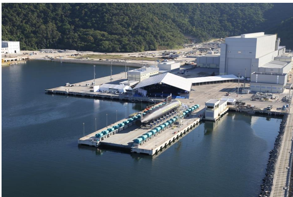
Complexe naval à Itaguai au Brésil, construit avec l'assistance technique de Naval Group. La société Itaguai Construções Navais, chargée de la construction des sous-marins Scorpène Brésil est détenue à 41% par Naval Group.
